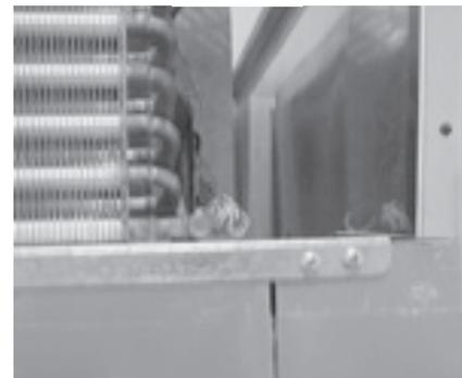
Avec le panneau de plafond monté en place, faites l'étanchéité des joints internes au mastic silicone. Insérez les boutons dans les trous des mécanismes de blocage.
